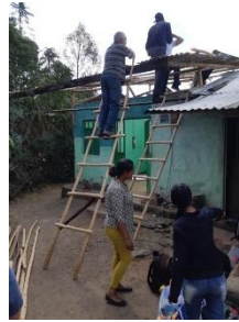
Aanbrengen nieuwe dakplaten
